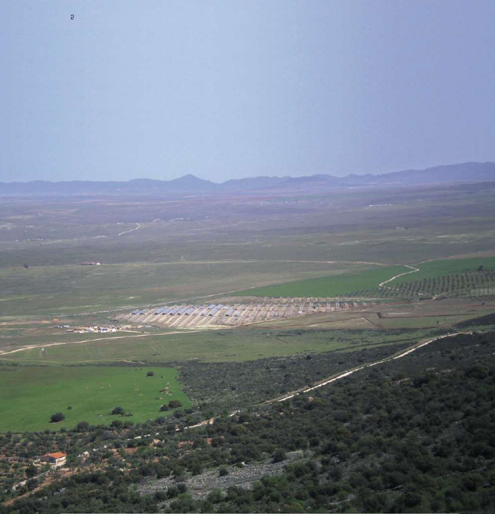
Solarkraftwerk in Badajoz, Spanien
