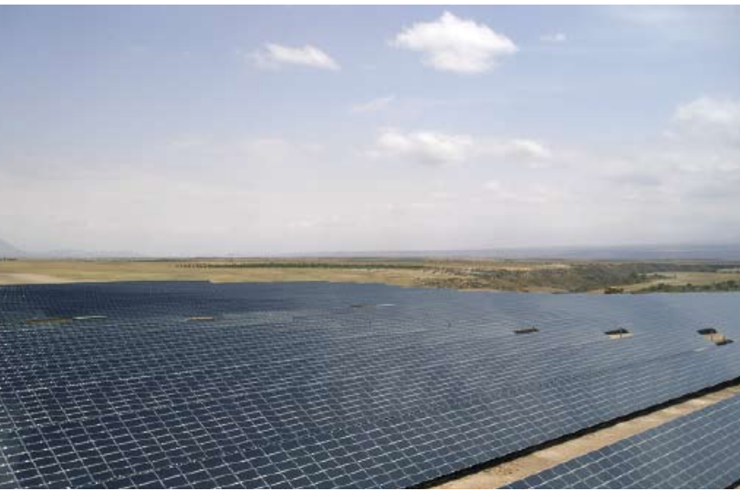
Bereits errichtete Anlagenteile der Solarkraftwerke Badajoz.
